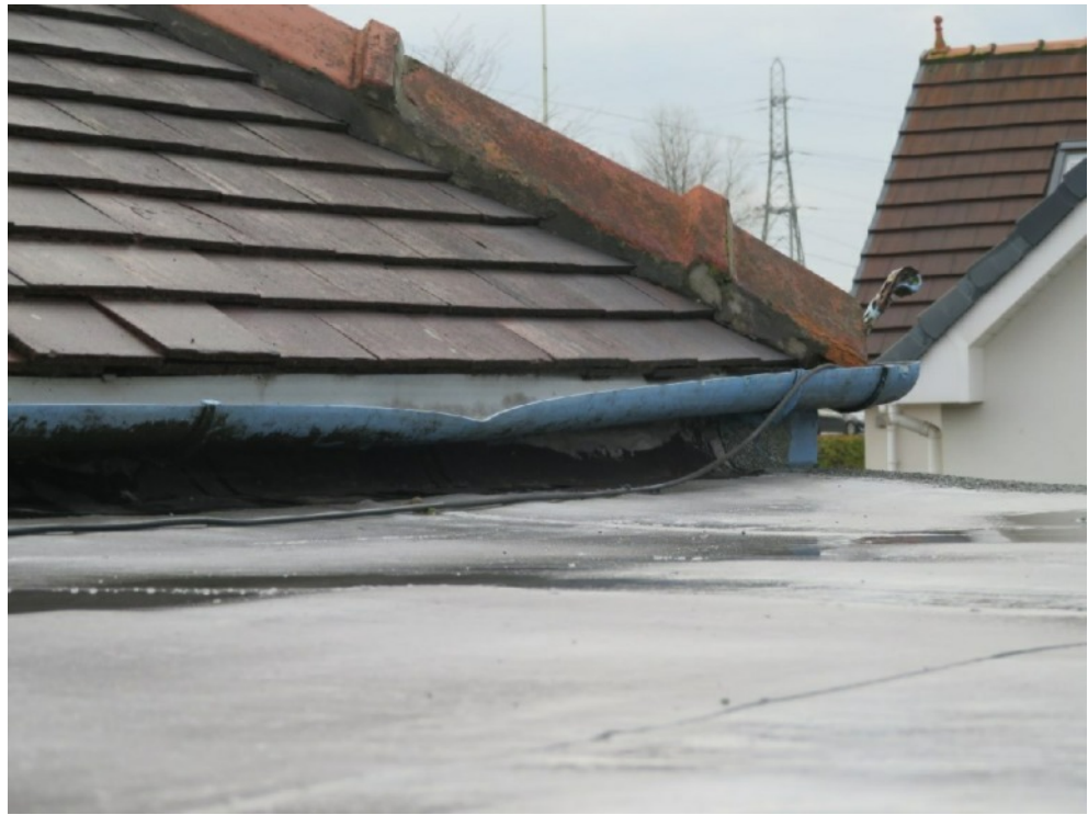
Bent gutter
